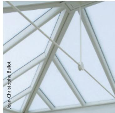
Les panneaux translucides diffusent la lumière sans que l'on puisse voir à travers. Réduction de la transmission d'ultraviolets.
