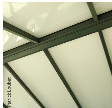
Les panneaux opaques (mousse entre deux panneaux aluminium) ne laissent pas passer la lumière et protègent contre la chaleur.
